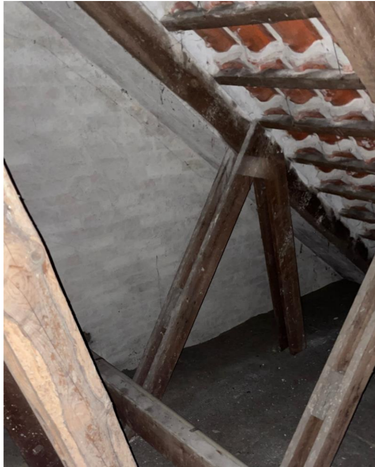
Gammel dansk tegltagsten med mørtel understrygning blok 12.
