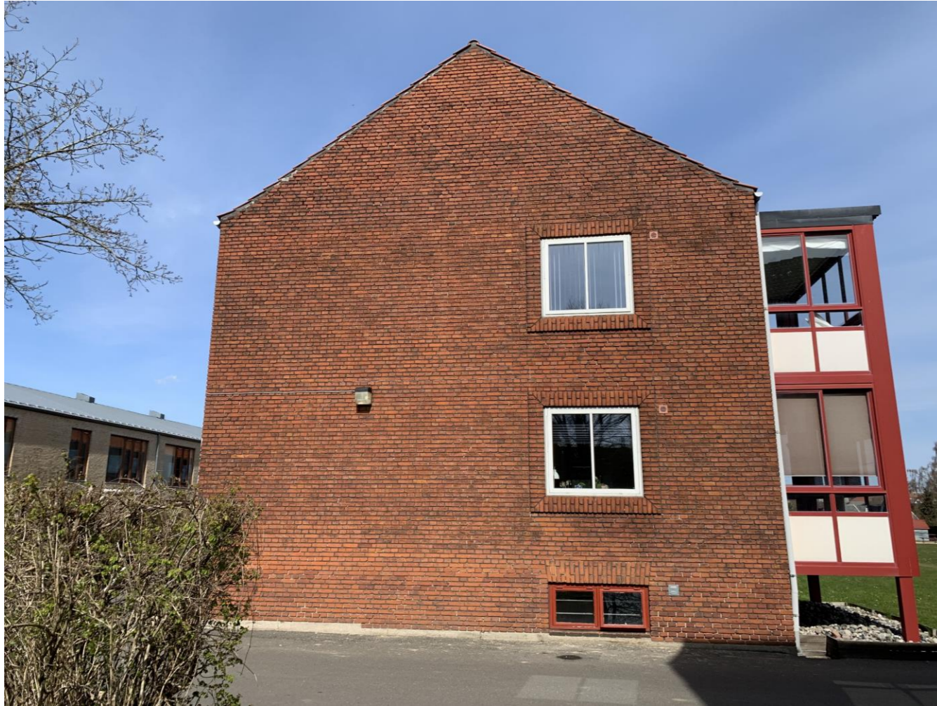
Eksisterende gavle nedrives.
