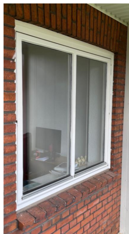
Eksisterende træ vindue mod lukket altan.
