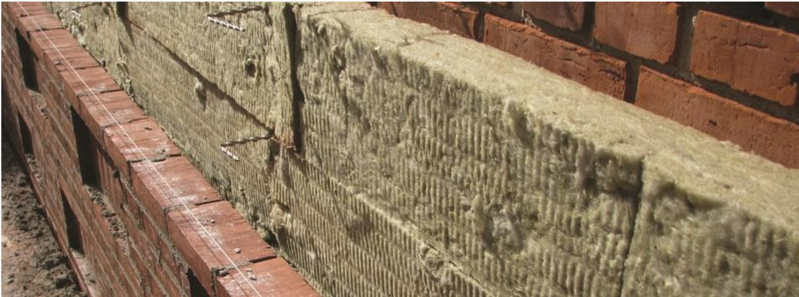
Eksempler på udvendig efterisolering.
